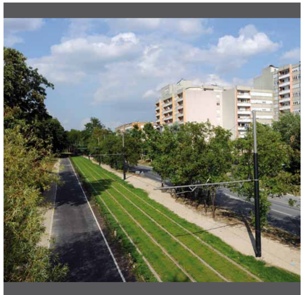
Dans un environnement entièrement repensé, la végétalisation de la ligne de tram embellit la ville.
